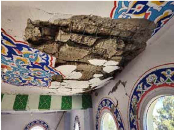
Şekil 172. Betonarme camilerde gözlemlenen döşeme hasarları
