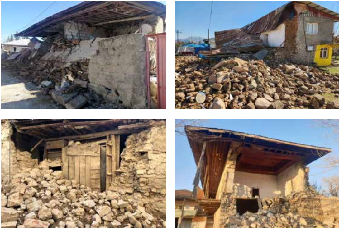
Şekil 92. Rijit diyafram davranışından yoksun bazı yığma binalar (Gaziantep İli İslahiye İlçesi ve Kahramanmaraş İli)
