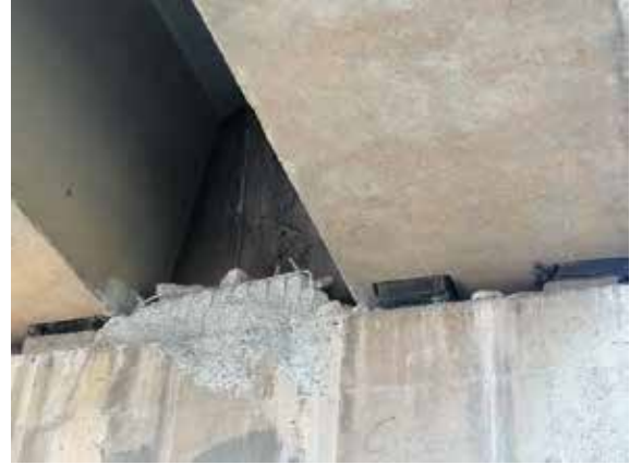
Şekil 117. Deprem takozu hasarlarına ait örnekler
