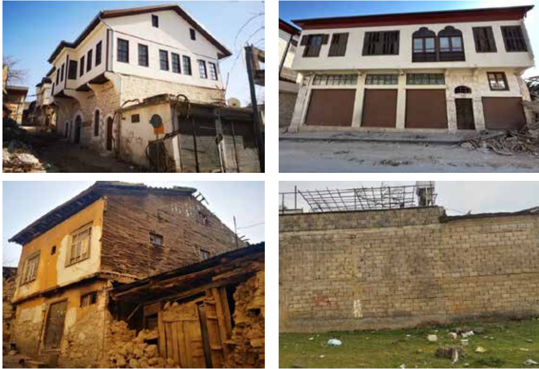
Şekil 97. Depremde iyi performans gösteren bazı yığma binalar (Kahramanmaraş İli, Hatay İli ve Gaziantep İli)
