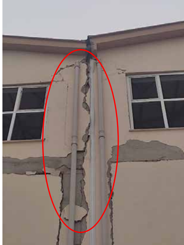
Şekil 104. Bitişik nizamda tasarlanmış betonarme sanayi yapıları (Kahramanmaraş)
