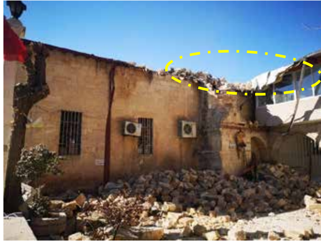
Şekil 147. Adıyaman Eskişaray Cami minare ve çatı hasarları
