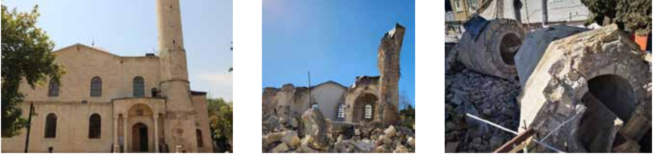
Şekil 137. Adıyaman Ulu Cami deprem öncesi (URL-6) deprem sonrası cami ve minare göçmesi
