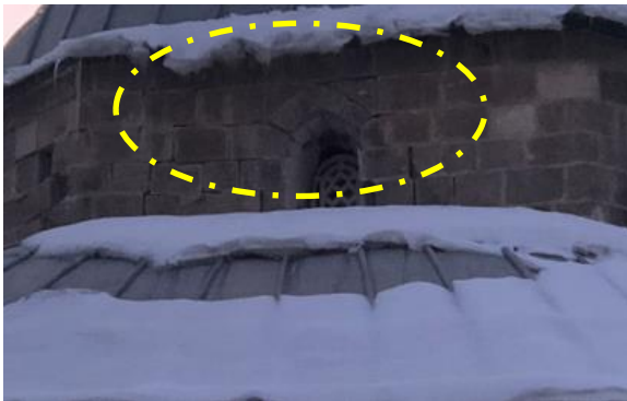
Şekil 144. Camii kubbesindeki pencere kenarlarında oluşan hasarlar
