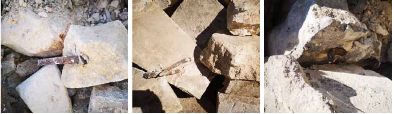
Şekil 138. Adıyaman Ulu Cami minaresinde kullanılan kenetler
