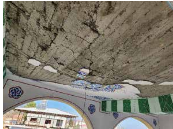
Şekil 172. Betonarme camilerde gözlemlenen döşeme hasarları
