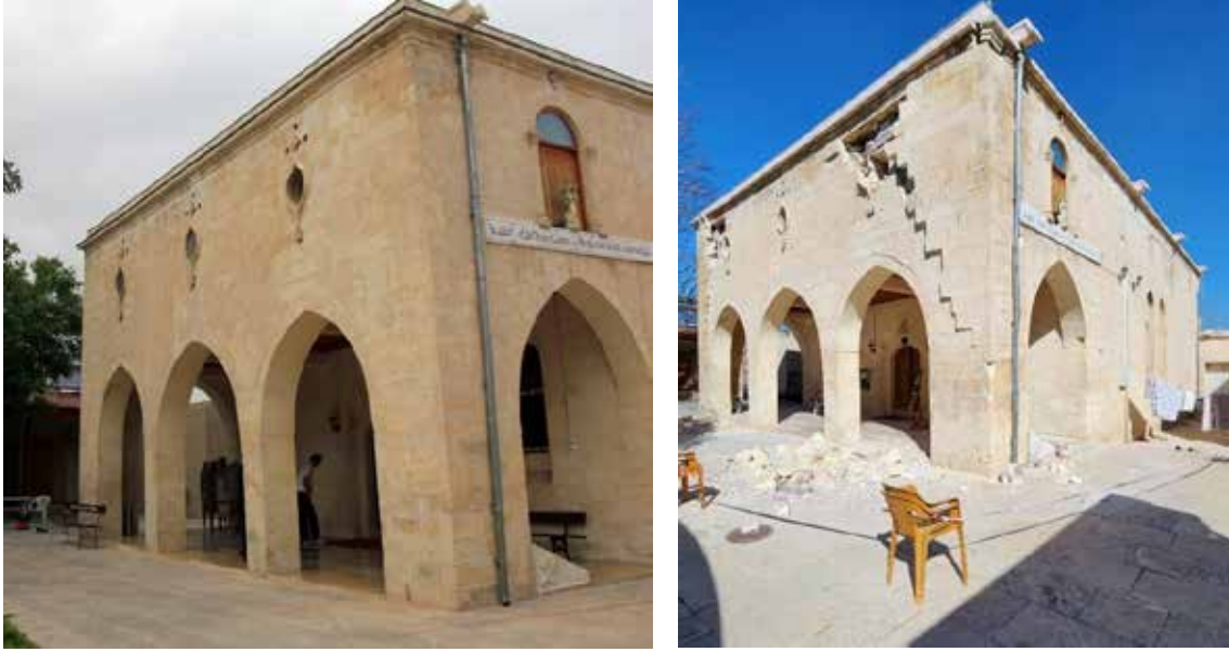
Şekil 131. Adıyaman Mor Petrus Kilisesi deprem öncesi (URL-6) ve deprem sonrası düzlem içi etkilerden kaynaklı hasar
