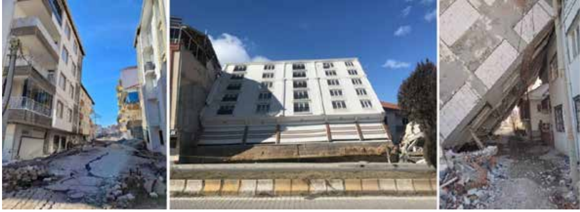
Şekil 58. Adıyaman Gölbaşı'nda zemin hasarı sonucu oluşan eğilme ve devrilmeler
