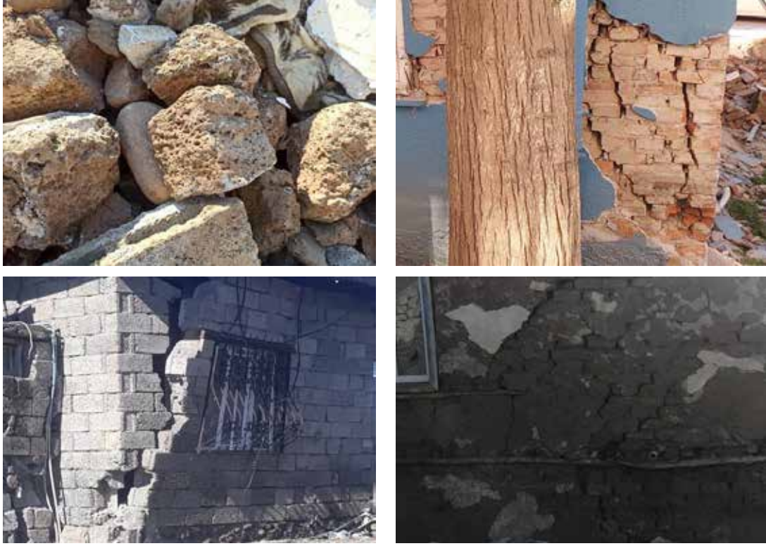
Şekil 84. Yığma duvar inşasında kullanılan düşük dayanımlı yığma birimler (Kahramanmaraş İli, Hatay İli ve Gaziantep İli, İslahiye İlçesi)
