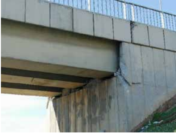
Şekil 117. Deprem takozu hasarlarına ait örnekler
