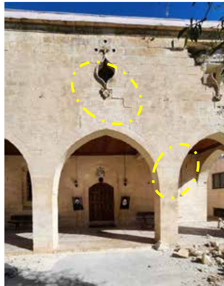
Şekil 134. Düzlem içi etkilerden kaynaklı diyagonal çekme çatlakları
