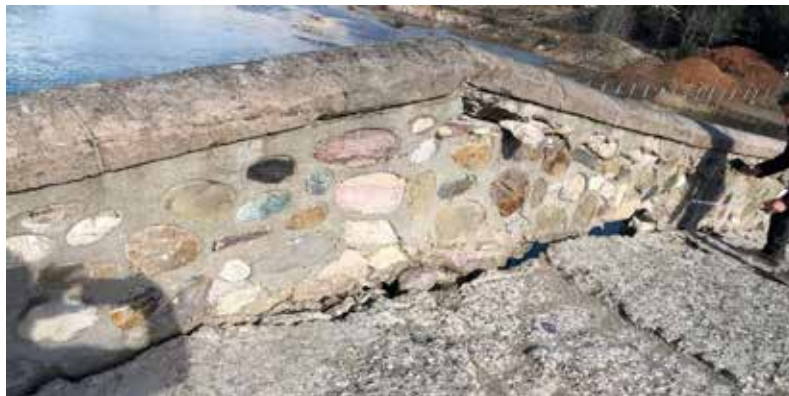
Şekil 128. Ceyhan (Taş) Köprüsü
