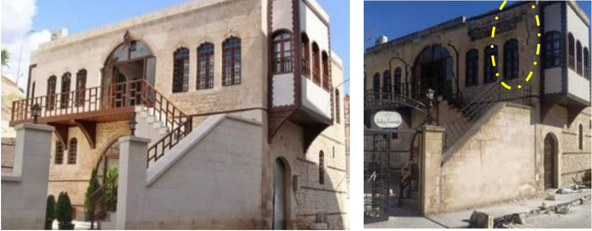
Şekil 156. Keleş Konağının depremden önce (URL-13) ve depremden sonra düzlem içi etkilerden kaynaklı hasar görüntüsü
