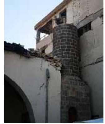
Şekil 148. Derviş Paşa Camii depremden önce (URL-11) ve depremden sonra minare göçmesi
