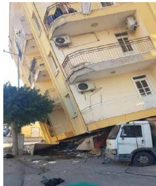
Şekil 76. Yumuşak kat durumuna ait örnek görseller
