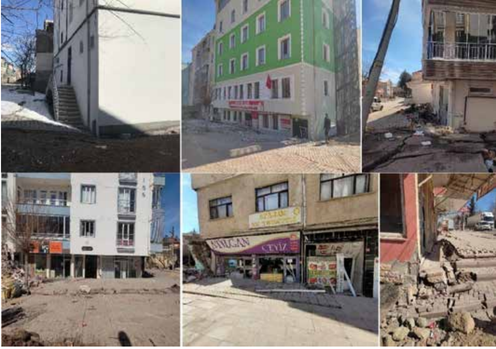
Şekil 56. Adıyaman Gölbaşı'nda zemin hasarı sonucu oluşan üniform bina oturmaları
