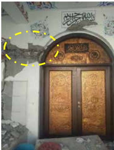
Şekil 168. Betonarme camilerde gözlemlenen mafsallaşma durumları
