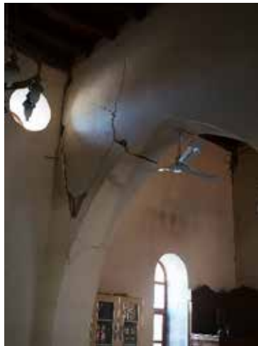
Şekil 149. Düzlem içi etkilerden kaynaklı diyagonal çekme çatlakları
