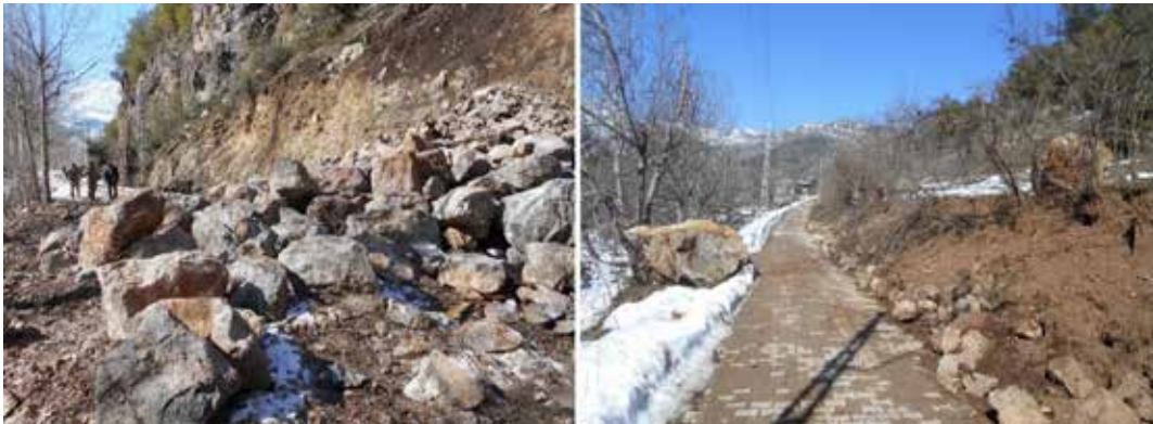
Şekil 61. Gaziantep İslâhiye Kökçü Mahallesi yolu üzerindeki kaya düşmeleri
