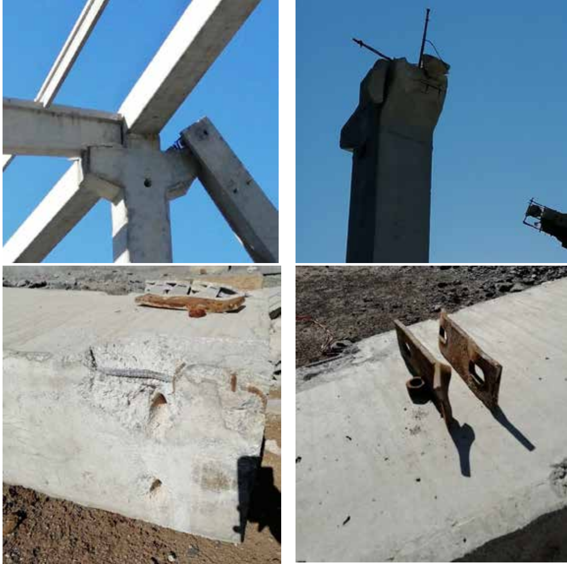
Şekil 110. Yetersiz bağlantı ve ekipmanları
