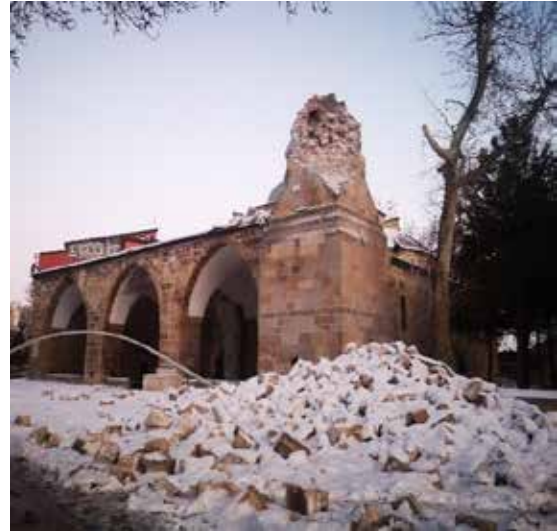
Şekil 143. Elbistan Ulu Camii deprem öncesi (URL-8) ve deprem sonrası minare göçmesi
