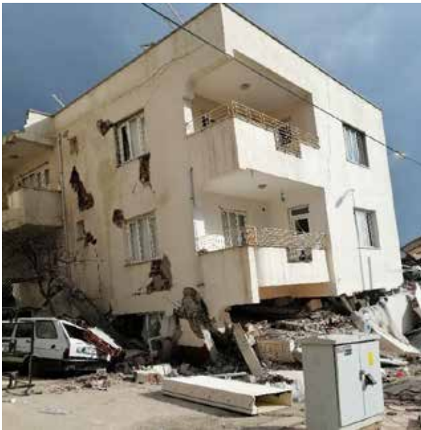
Şekil 76. Yumuşak kat durumuna ait örnek görseller
