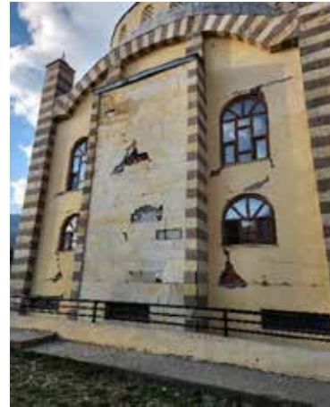
Şekil 173. Betonarme camilerde gözlemlenen bölme duvar hasarları
