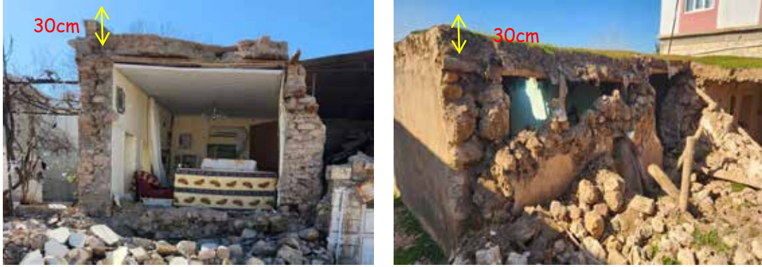
Şekil 85. Bazı yığma binalarda ağır toprak dam çatılar (Adıyaman İli)
