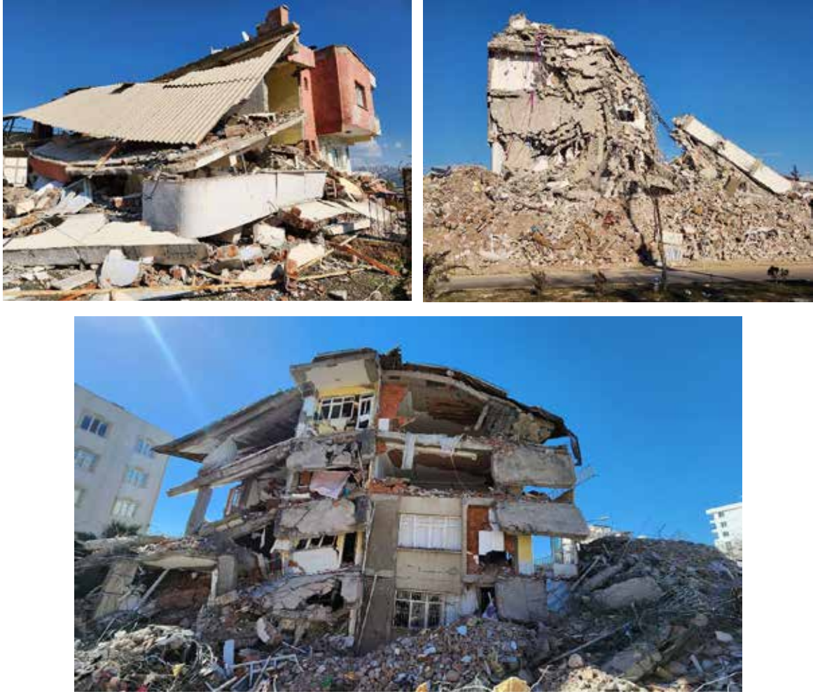
Şekil 74. Yapısal düzensizliklere örnek görseller
