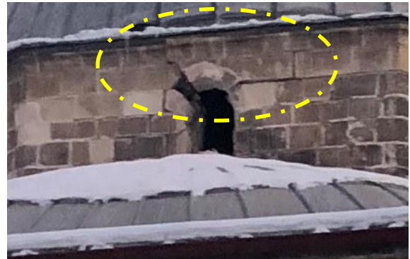
Şekil 144. Camii kubbesindeki pencere kenarlarında oluşan hasarlar
