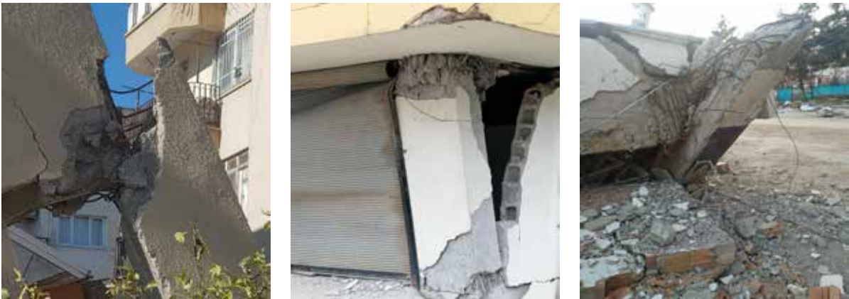
Şekil 67. Kahramanmaraş Pazarcık ve Elbistan Depremlerinde tespit edilen kolon-kiriş birleşim hatalarından kaynaklı yapısal hasarlar
