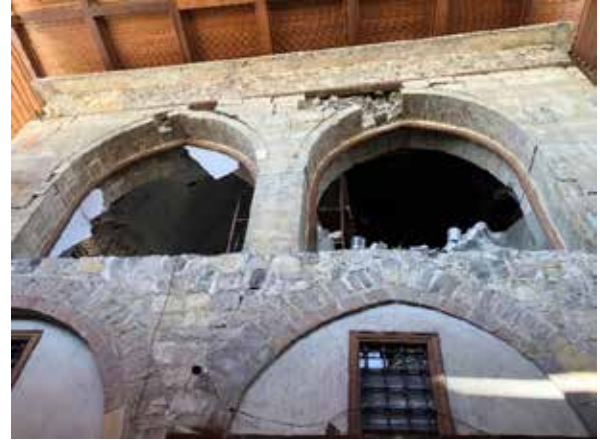
Şekil 153. Düzlem içi etkilerden kaynaklı diyagonal çekme çatlakları oluşan hasarlar
