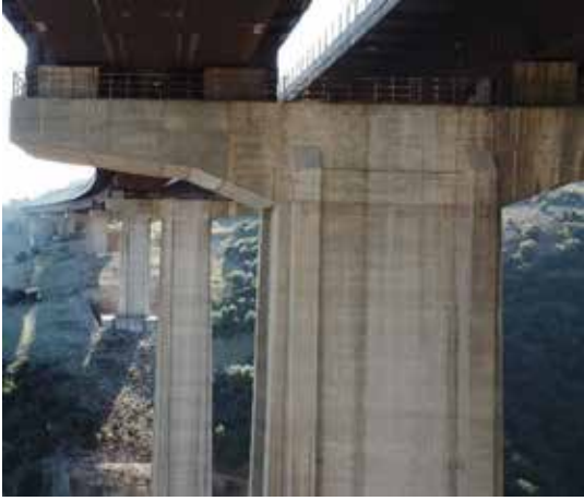
Şekil 117. Deprem takozu hasarlarına ait örnekler
