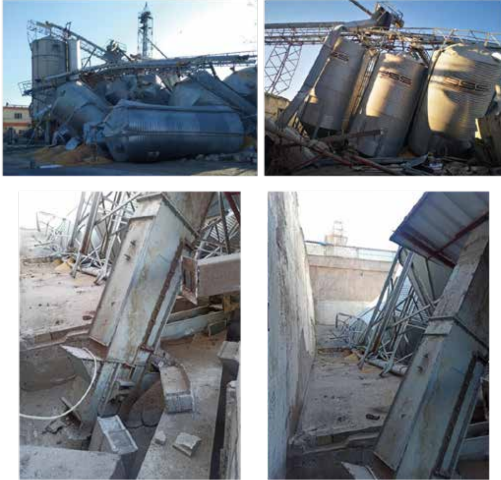
Şekil 99. Depremde büyük oranda yıkılan bir çelik tahıl deposu örneği (Gaziantep)
