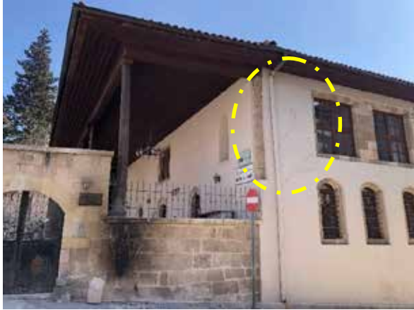
Şekil 153. Düzlem içi etkilerden kaynaklı diyagonal çekme çatlakları oluşan hasarlar
