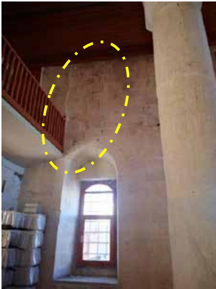
Şekil 134. Düzlem içi etkilerden kaynaklı diyagonal çekme çatlakları
