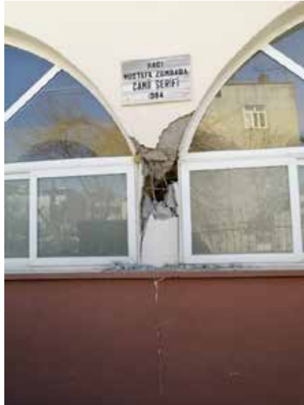
Şekil 171. Betonarme camilerde gözlemlenen kısa kolon hasarları
