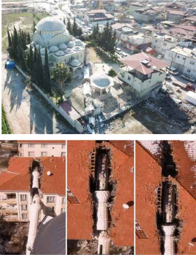
Şekil 181. Minarelerin yıkılması sonucu yakınında bulunan yapılarda oluşan hasarlar (URL-18)
