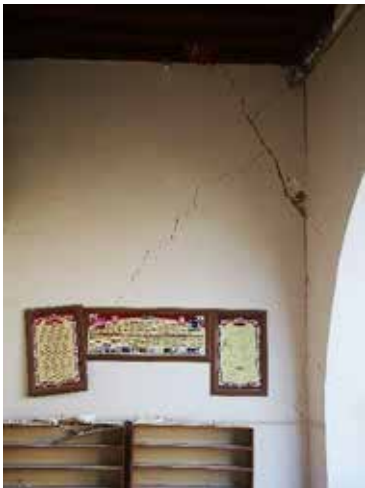
Şekil 149. Düzlem içi etkilerden kaynaklı diyagonal çekme çatlakları
