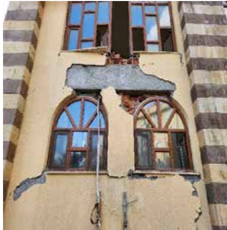
Şekil 173. Betonarme camilerde gözlemlenen bölme duvar hasarları
