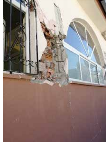
Şekil 171. Betonarme camilerde gözlemlenen kısa kolon hasarları
