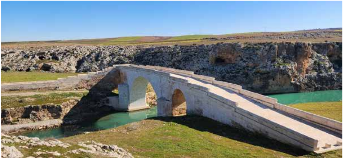
Şekil 126. Kızılın (Sıngas) Köprüsü
