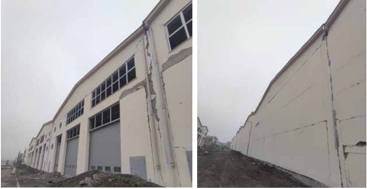
Şekil 103. Yerinde döküm betonarme sanayi yapıları (Kahramanmaraş)
