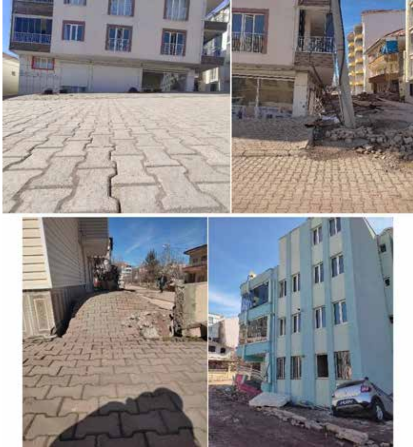
Şekil 57. Adıyaman Gölbaşı'nda zemin hasarı sonucu oluşan farklı oturmalar
