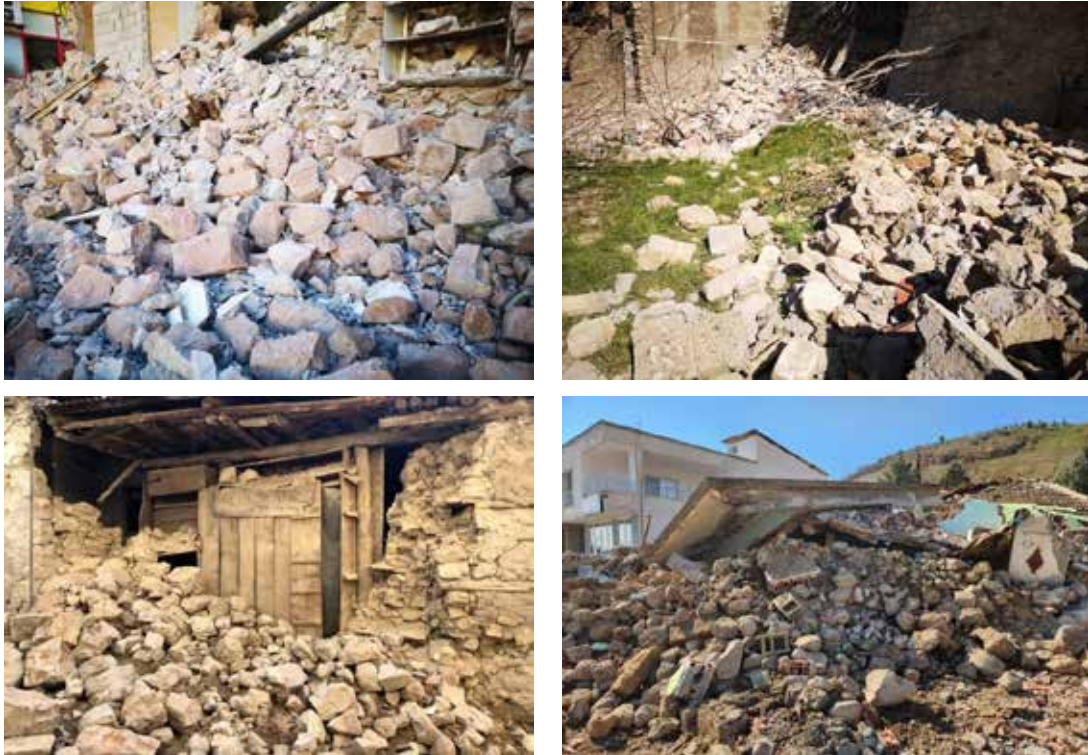
Şekil 83. Yığma duvar inşasında kullanılan pürüzsüz ve şekilsiz (keskin köşelere sahip) moloz taşlar (Kahramanmaraş İli ve Gaziantep İli, İslahiye İlçesi)
