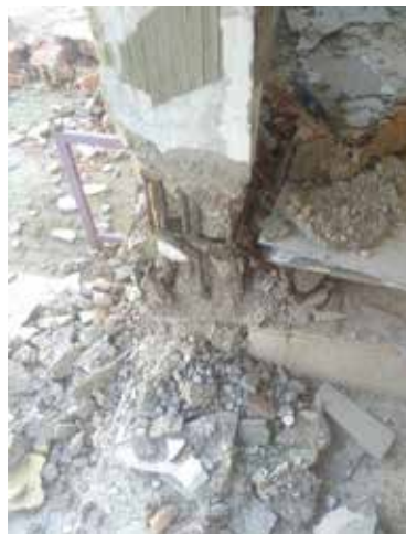
Şekil 168. Betonarme camilerde gözlemlenen mafsallaşma durumları
