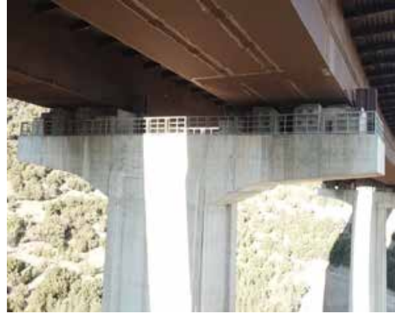
Şekil 117. Deprem takozu hasarlarına ait örnekler
